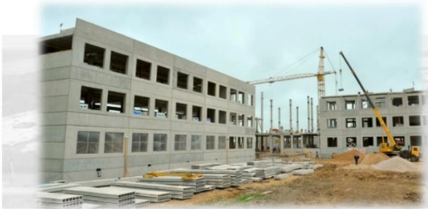
Строительство ООШ на 100 мест в дер. Сухое Кировского р-на
